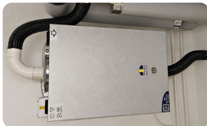
Radonsug SRS installerad med smalrörskit 160/050.
