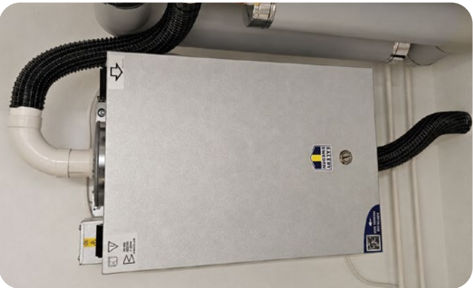
Radonsug SRS installerad med smalrörskit 160/050.
