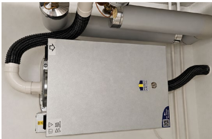
Radonsug SRS installerad med smalrörskit 160/050.
