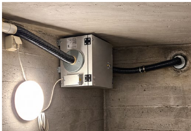
Radonsug SRS installerad med smalrörskit 160/050.
